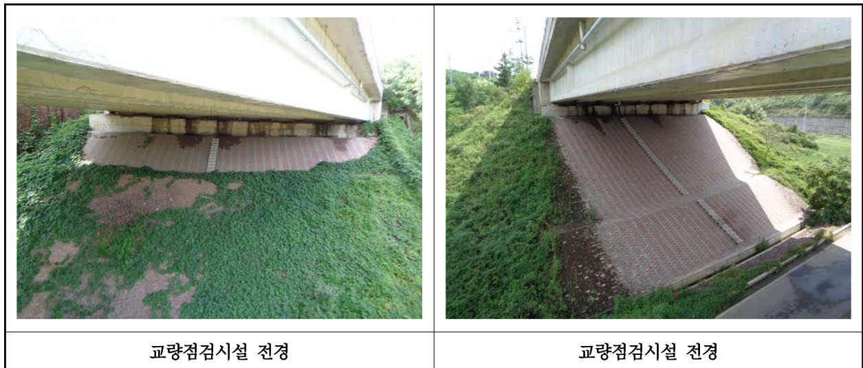
【사진 19.3.25】 교량 점검시설 전경
