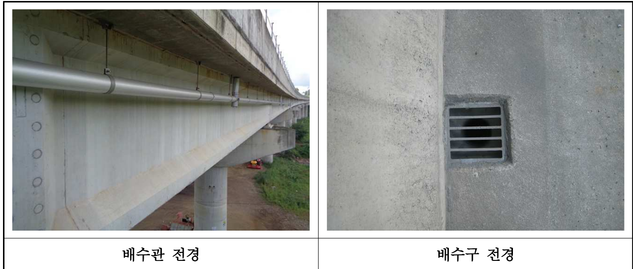
【사진 19.3.21】 배수시설 전경
