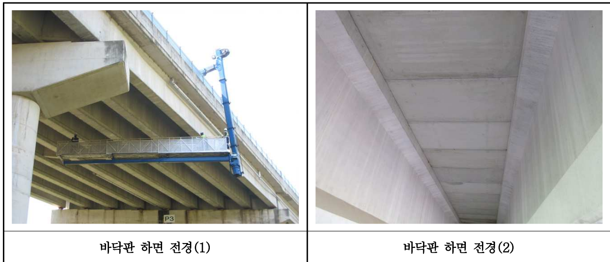
【사진 19.3.2】 바닥판하면 전경
