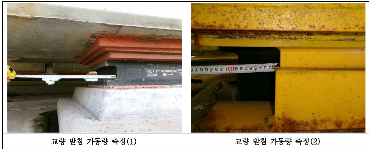
【사진 19.3.15】 교량받침 이동량 측정
