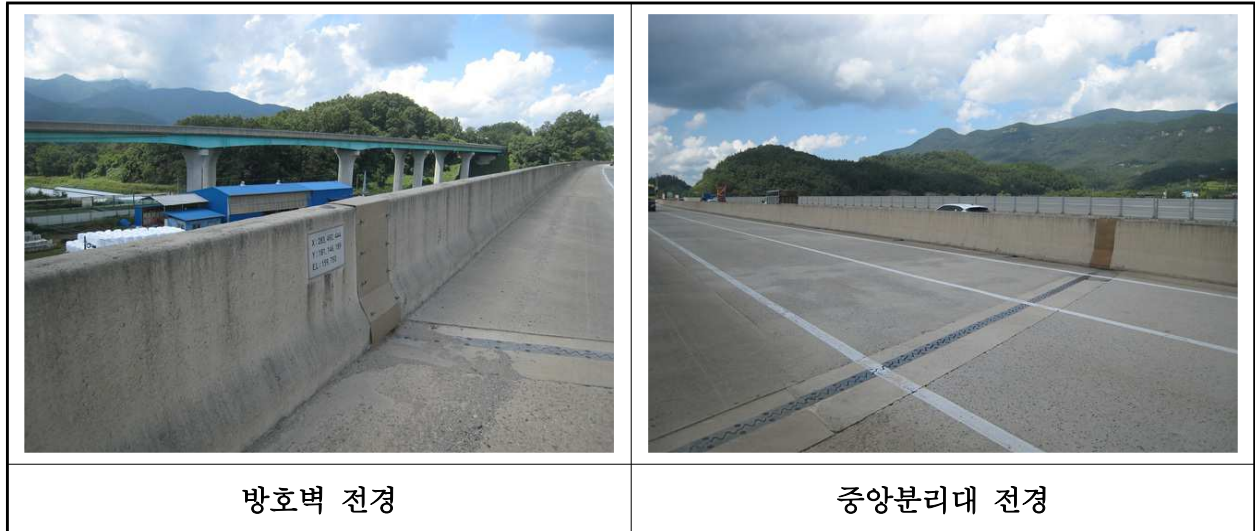
【사진 19.3.23】 방호벽 및 중앙분리대 전경
