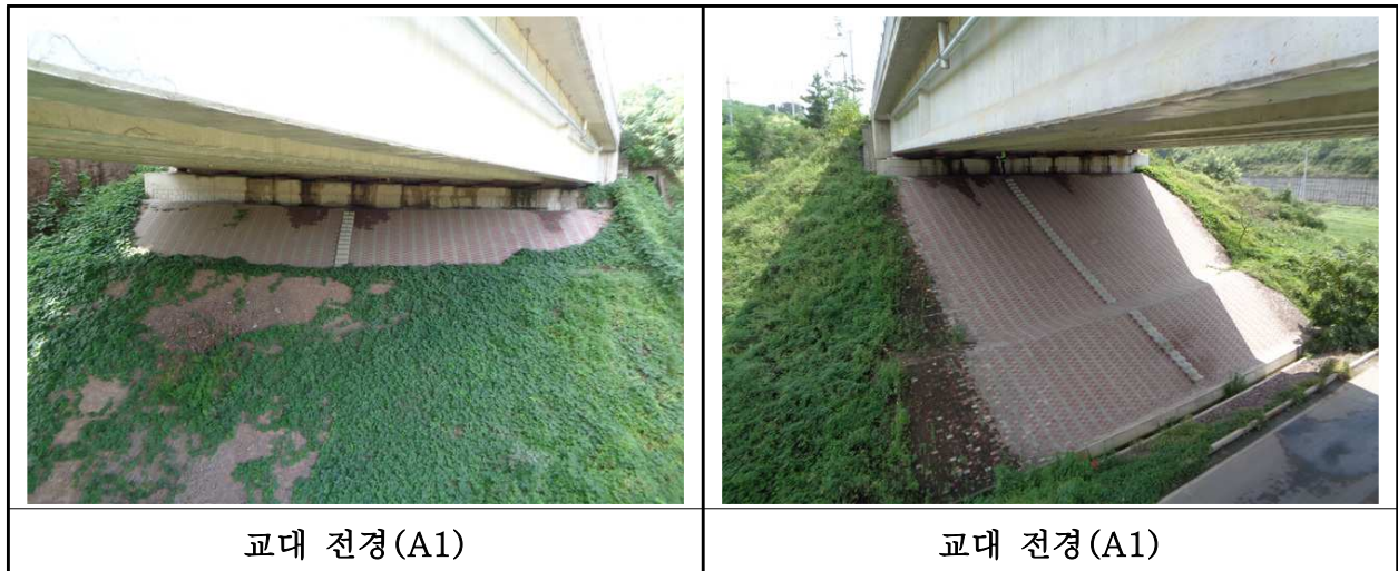
【사진 19.3.8】 교대 전경
