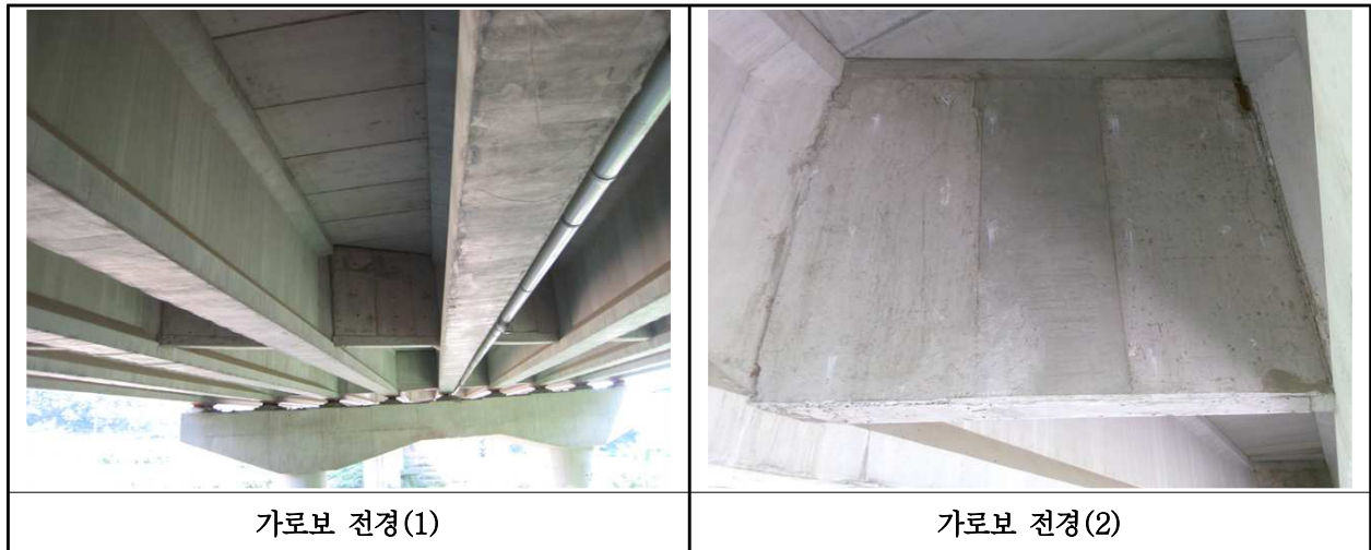
【사진 19.3.6】 가로보 전경
